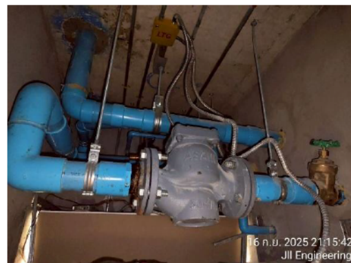
รูปที่ 3.1-20 ตรวจสอบรอยรั่วของท่อจ่ายน้ำ และท่อระบายน้ำ
