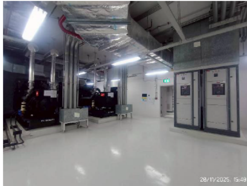
รูปที่ 3.1-22 หม้อแปลงไฟฟ้า และเครื่องสำรองไฟฟ้า (ต่อ)
