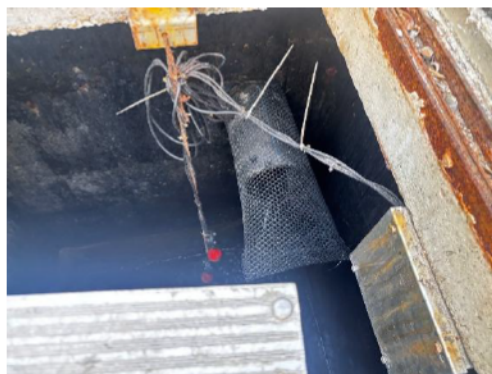
รูปที่ 3.1-6 ติดตั้งตะแกรงดักมูลฝอยที่บ่อบำบัดน้ำสุดท้าย
