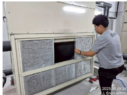
รูปที่ 3.1-40 การล้างแผ่นกรองอากาศและเครื่องปรับอากาศในพื้นที่ส่วนกลาง
