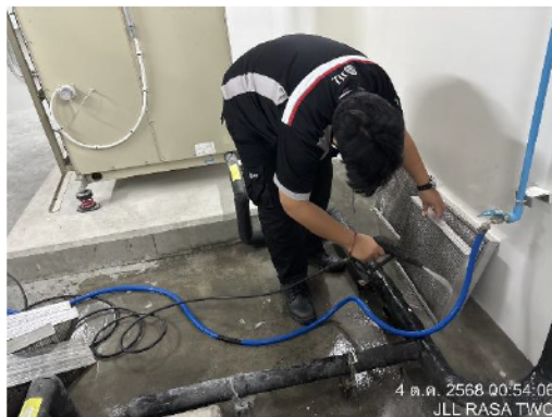
รูปที่ 3.1-40 การล้างแผ่นกรองอากาศและเครื่องปรับอากาศในพื้นที่ส่วนกลาง
